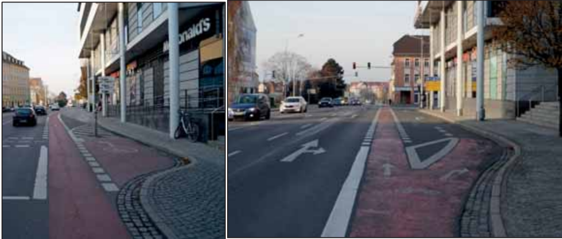
Abb. 21 Radverkehrsführung im Zuge des Lauengrabens
