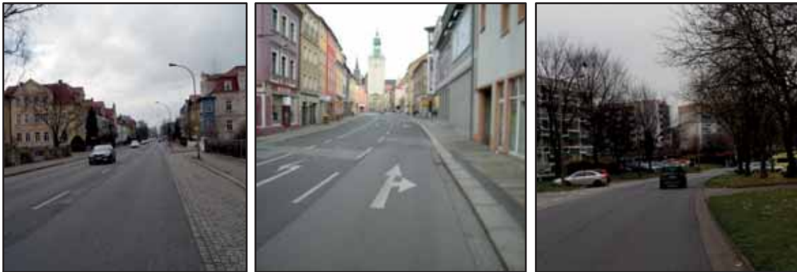
Abb. 25 Netzlücken innerorts (Stieberstr., Äußere Lauenstr., Gesundbrunnenring)
